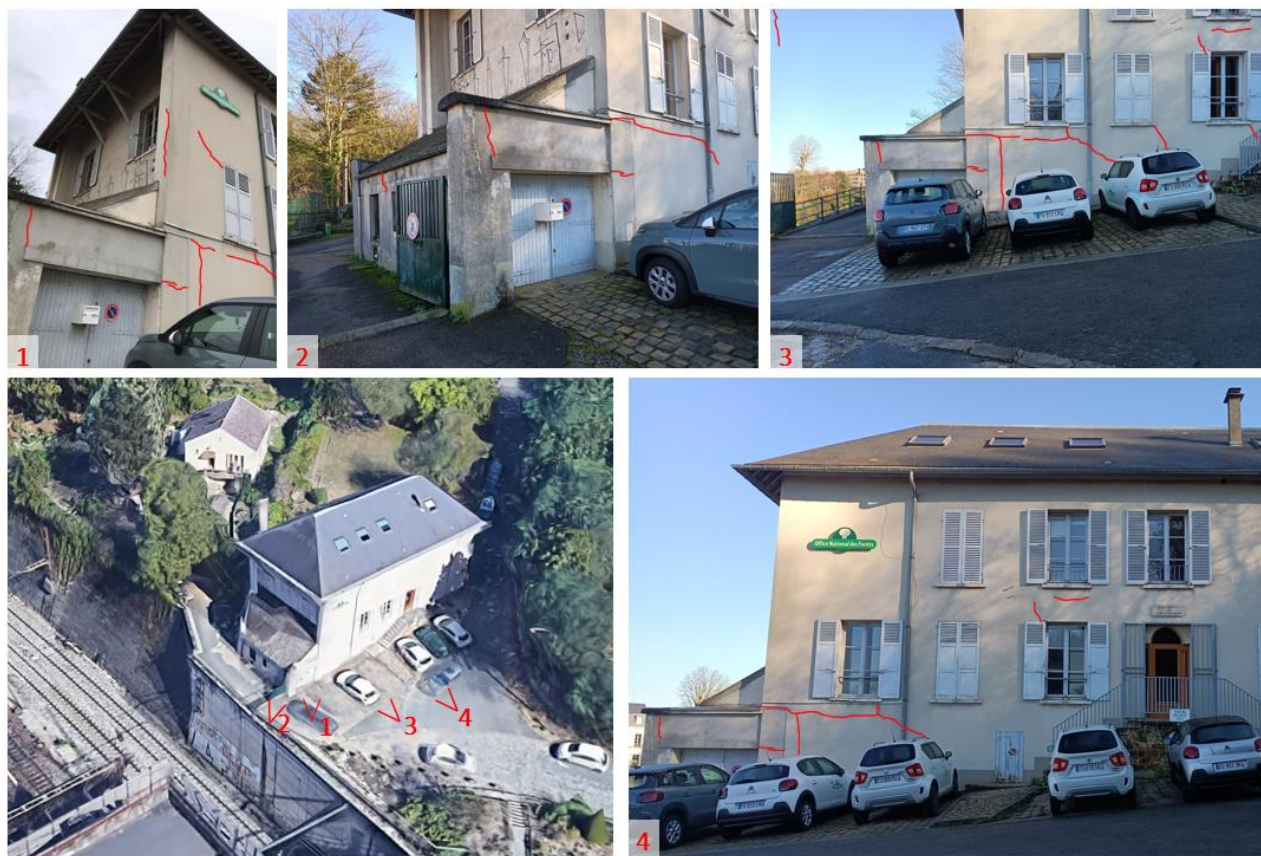
Figure 31. Repérage des fissurations – janvier 2022
