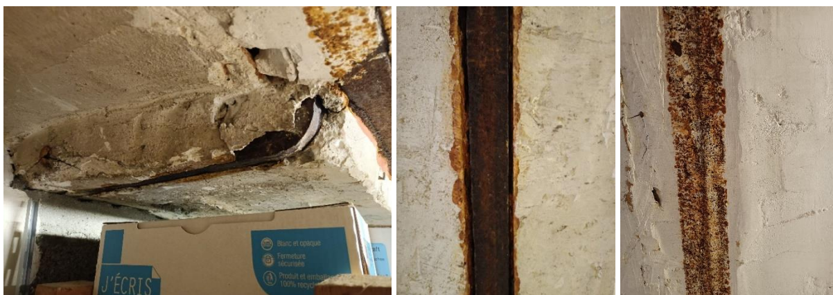
Figure 28. Photographies effectuées lors des reconnaissances du 14/04/2022 – corrosion superficielle
