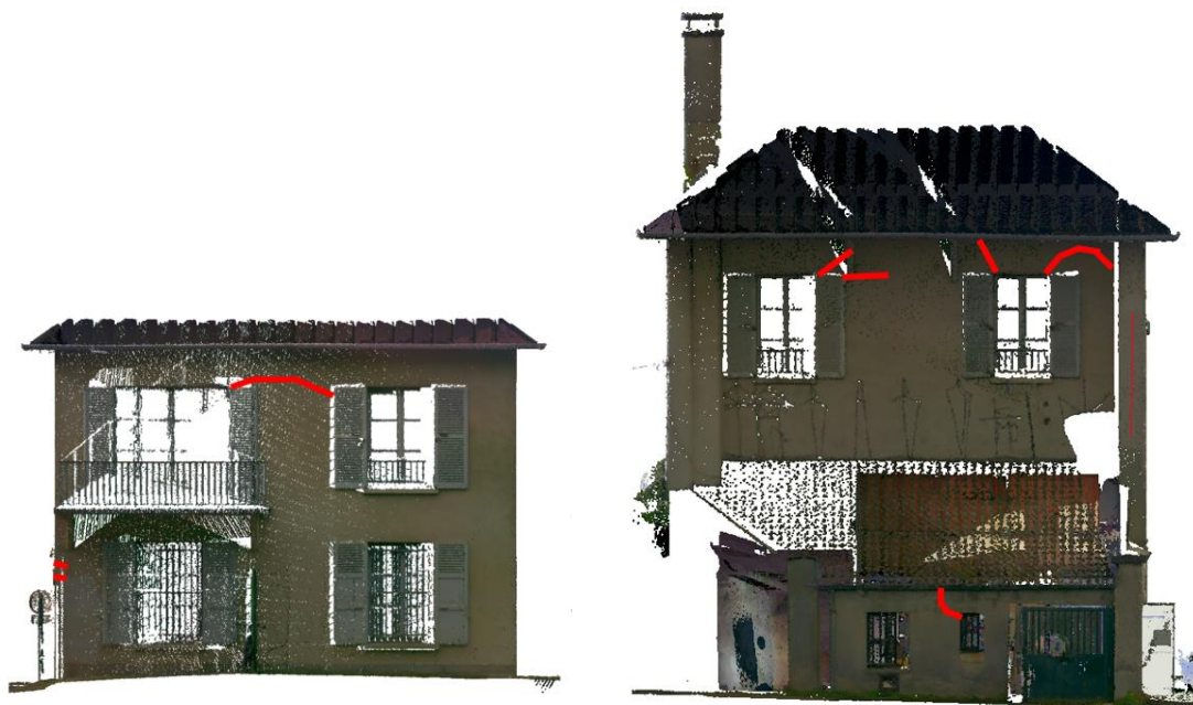
Figure 32. Repérage des fissurations, façades sud-Est et Nord-Ouest – janvier 2022
