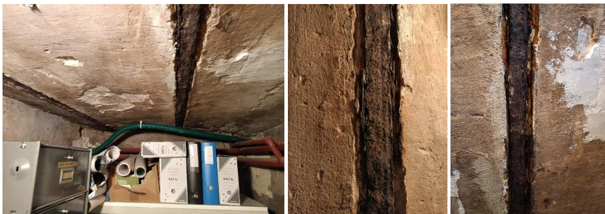
Figure 27. Photographies effectuées lors des reconnaissances du 14/04/2022 – zone de corrosion avancée
