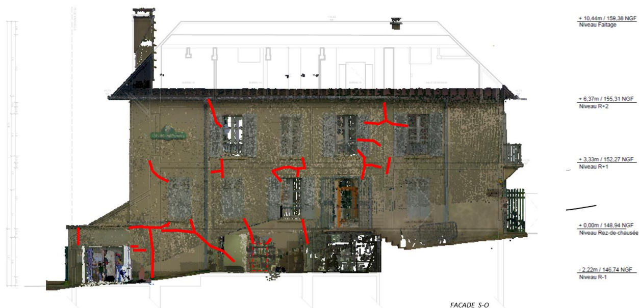
Figure 33. Repérage des fissurations, façade sud-Ouest – janvier 2022
